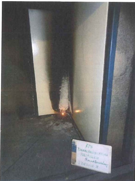
Bild 8: Prüfkörper „Tunnelbeschichtungssystem POLIFUKRIE“ (Beschichtungsdicke 400 µm) nach dem Versuch 2 – Nahaufnahme der Außenkante
